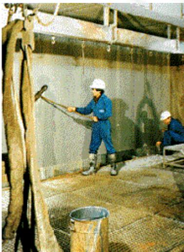
**Bild 14-1: Grundreinigung eines wasserberieselten Farbspritzstandes**
